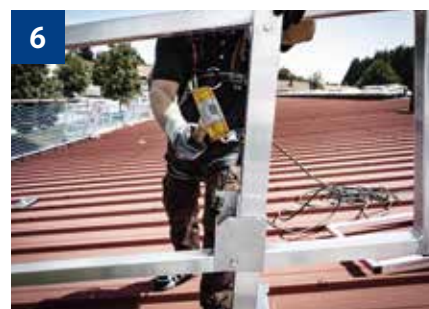
6 Geländer mittels Keilsicherung fixieren.
