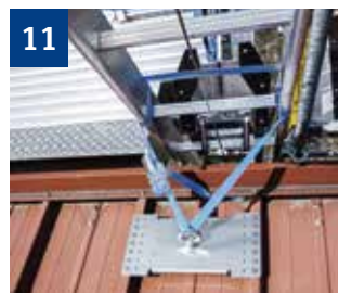
11 Stützleitern mit Zurrgurt verankern.
