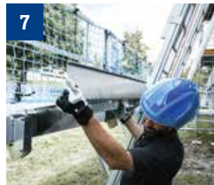
7 Bei Bedarf Überbrückungsblech mit Bordbrett montieren.
