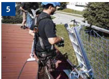
Geländer (und Netz) befestigen.
