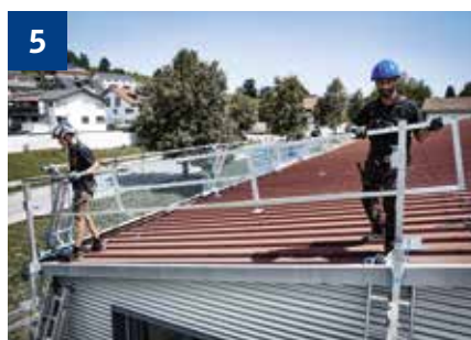
5 Geländer in Pfosten einhängen.
