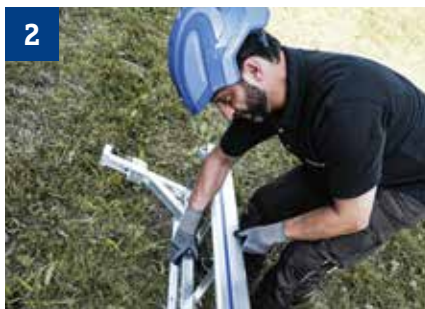
Geländerpfosten auf den Leitern befestigen.
