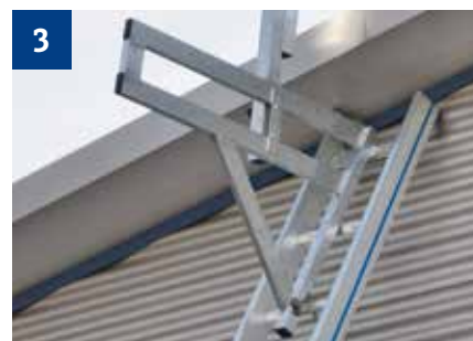
3 Leitern aufrichten und bis unter den Dachüberstand ausfahren.
