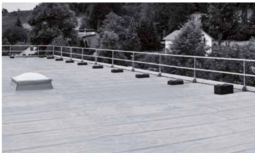
Aufbauvariante NEO 30
