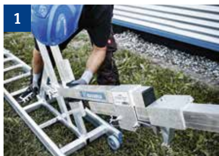
1 Geländerpfosten auf den Leitern befestigen.
