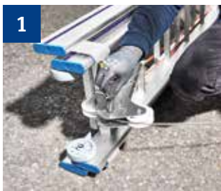
1 Umlenkrolle und Seilwinde an den Stützleitern montieren und Seil einfädeln.
