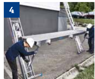
4 Arbeits-Plattform und Stütze auf dem Transport-Schlitten einhängen.
